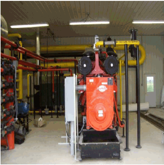
Digester gen-set & switchgear (7/16/2010)
